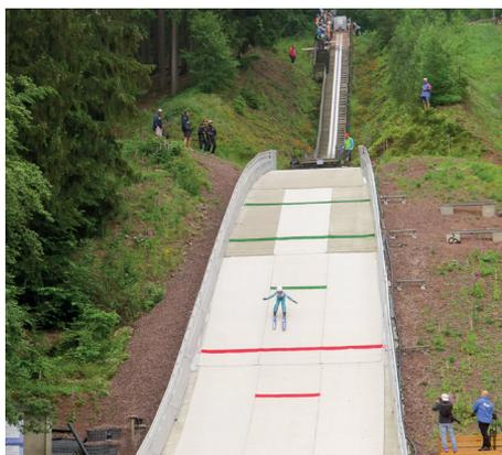
aufgebracht werden müssen, da der Schnee sonst abrutscht. Des Weiteren muss eine Schneeauflage von ca. 30 cm auf der Schanze liegen, um darauf Springen bzw. Landen zu können. Auf der Steinbach-Hallenberger Schanze wurde mit deren Sanierung eine neuartige „Matte“ von Mr. Snow aufgebracht. Es handelt sich um eine aus Spezialgewebe gefertigten Matte. Aufgrund einer gewissen Maschenform und Faserart ist die Reibung dieser Matte geringer als bei der herkömmlichen.
